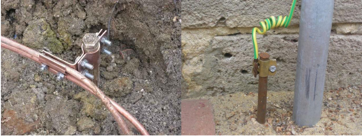
Şekil 1. Topraklama Fotoğrafları
